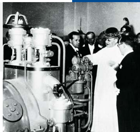
Bereits 1932 wurde eine Fernheizung im Vatikanstaat errichtet. Papst Pius XI bei der Ortsbesichtigung.
